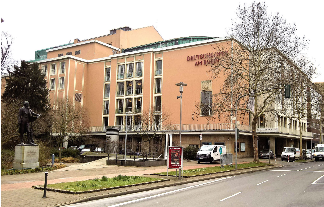
Das zweigeteilte Opernhaus mit Zuschauerraum und Portal (1956) sowie Bühnentrakt (1875)
