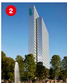
Das Dreischeibenhaus vom Hofgarten im Norden aus © Dreischeibenhaus GmbH & Co. KG
