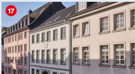
Das denkmalgeschützte Schumann-Haus in der Bilker Straße 15 © Markus Luigs
